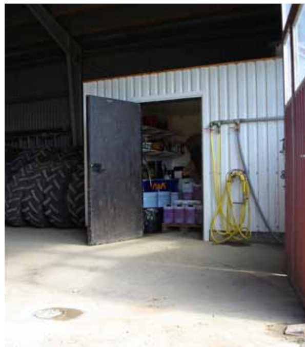
För bästa arbetsmiljö är ett avlopp med vattenlås i förbindelse med en uppsamlingstank som placeras utomhus att föredra.
