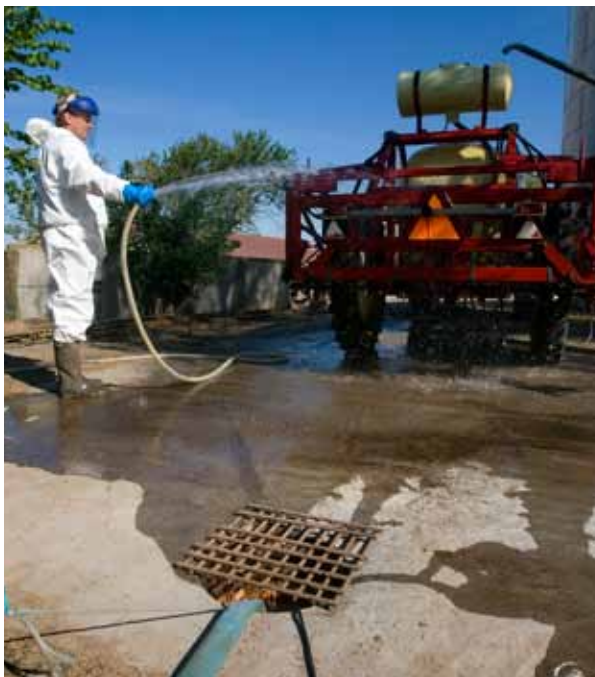
En platta kopplad till gödselbehållare sväljer stora mängder vatten både från nederbörd och tvätt av sprutekipaget.
