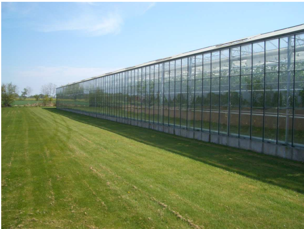
Figur 6. Traditionellt svenskt växthus med stålkonstruktion. Foto: Torbjörn Hansson.
