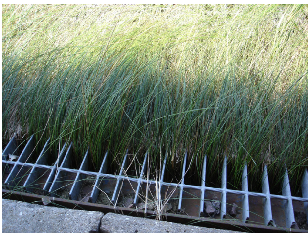
Tänk på att gallerdurken ska vara så grovmaskig att solljuset når fram. Foto: HIR Skåne
